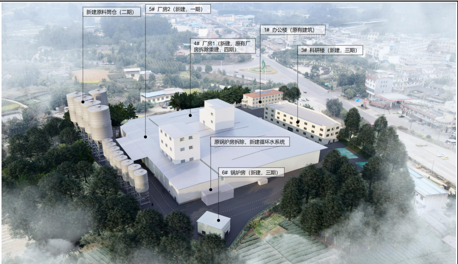
建筑实景鸟瞰图 (调整前)
